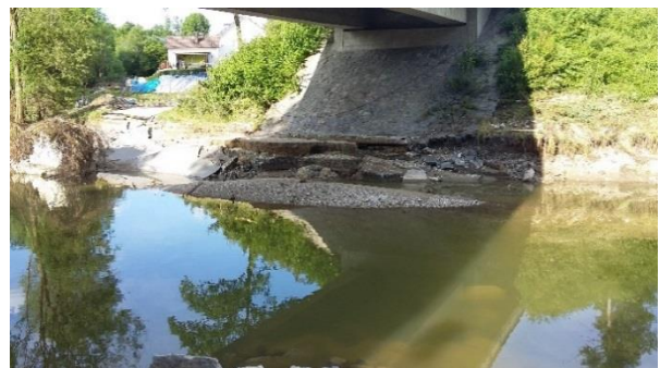
Bild: Zufahrt zur Kläranlage nach dem Hochwasser – links im Bild ein Fundament der zerstörten Radwegbrücke
